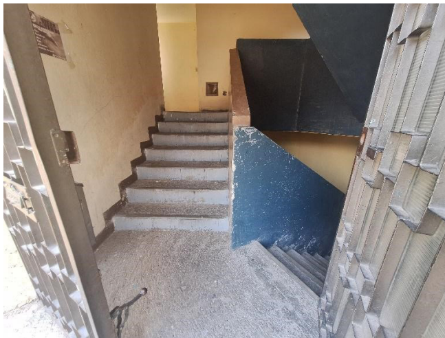
Imagen 5. Escaleras de la torre de viviendas
